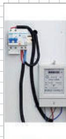
漏电保护装置
