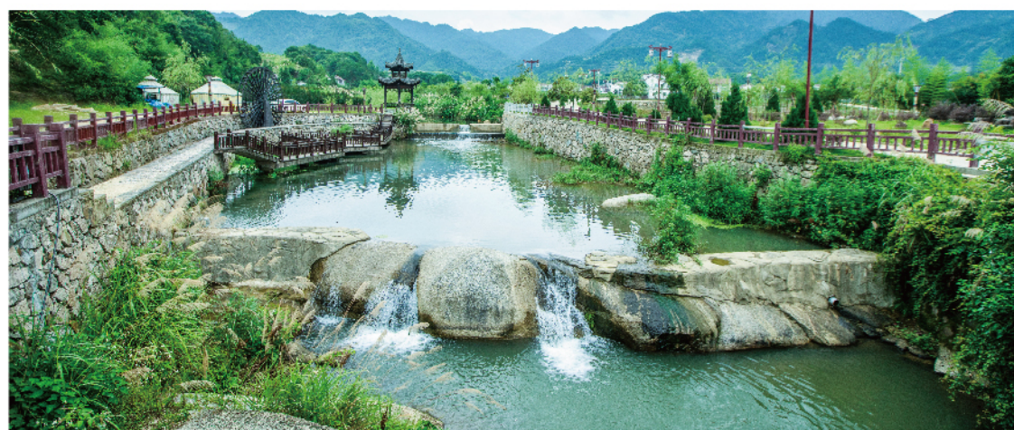
岳西县龙头河小流域（堰坝+生态护岸+亲水平台）
