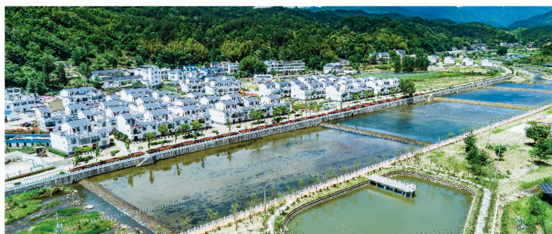
金寨县杨柳河小流域（堰坝+生态步道+植物措施+湿地）
