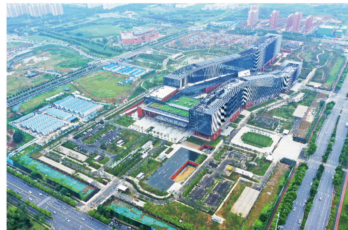
中国科学院量子信息与量子科技创新研究院建设项目一期工程
