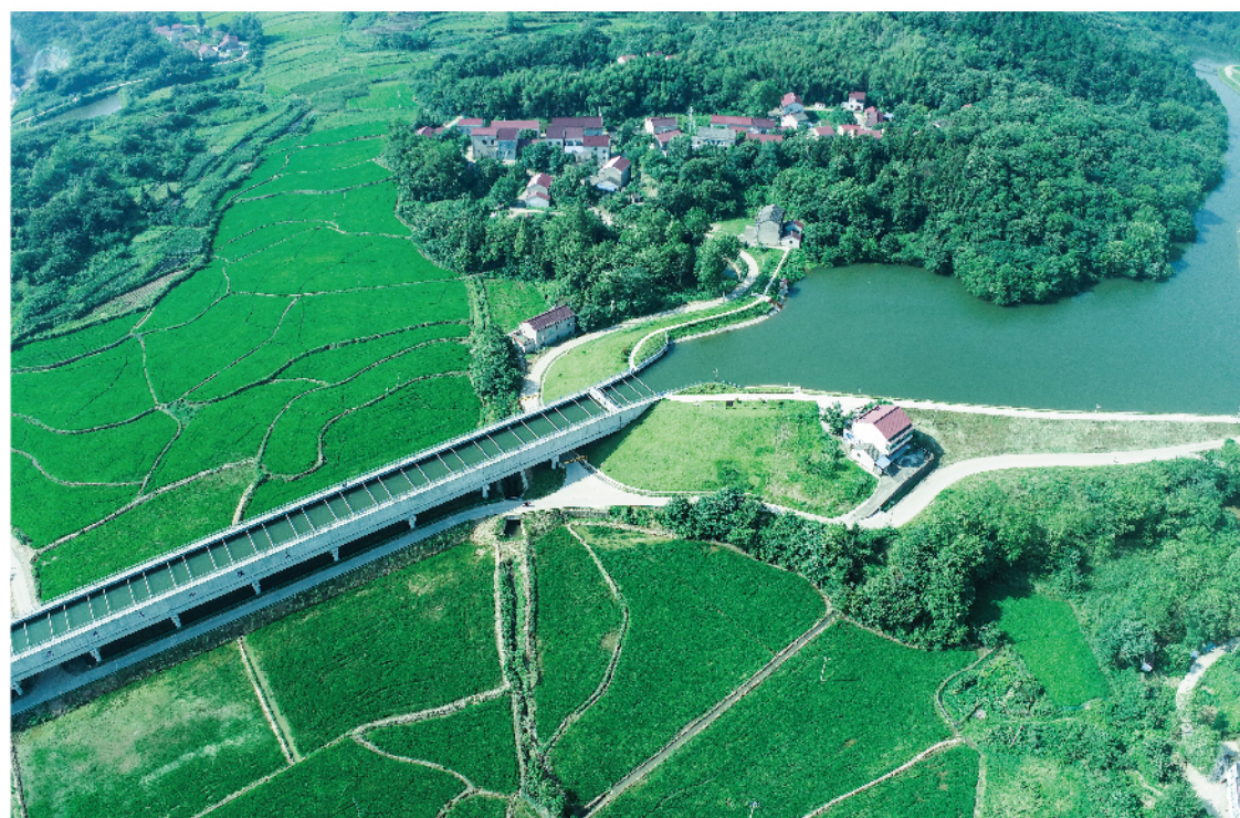
淠史杭灌区续建配套与节水改造工程（2019~2020年）
