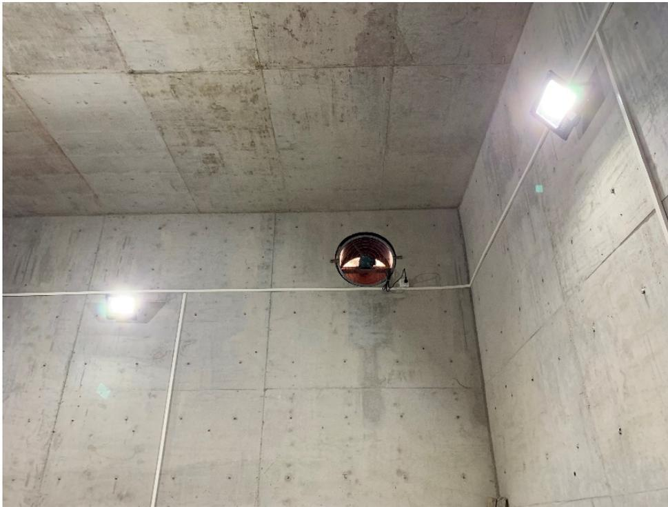
图 4-7 室内排风装置实物图
