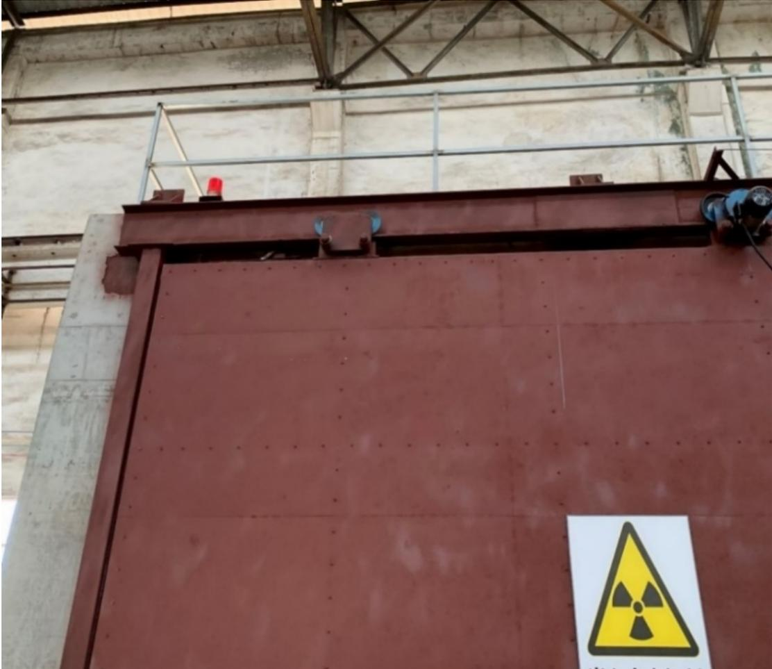
图 4-2 声光警示装置实物图
