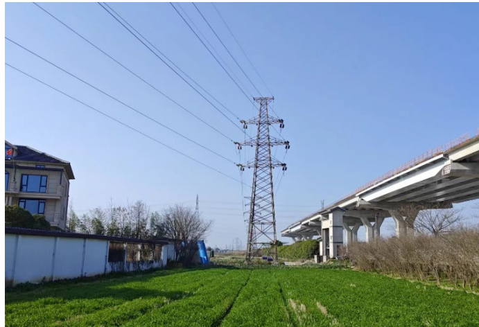
图 3-1 现有塔基架设植被恢复情况
