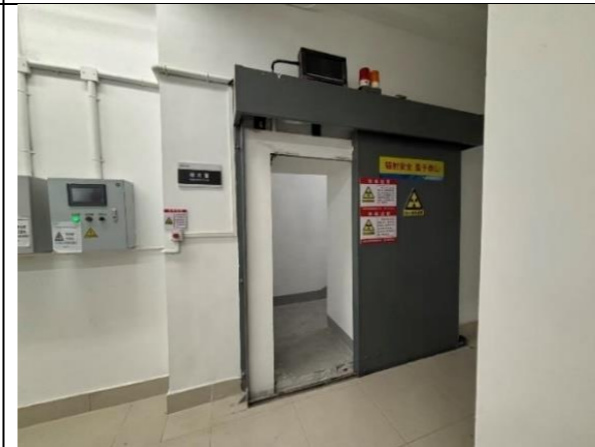
人员进出门设置工作状态指示灯、意义说明、报警灯、电离辐射警告标志，操作室设置固定式在线监测仪
