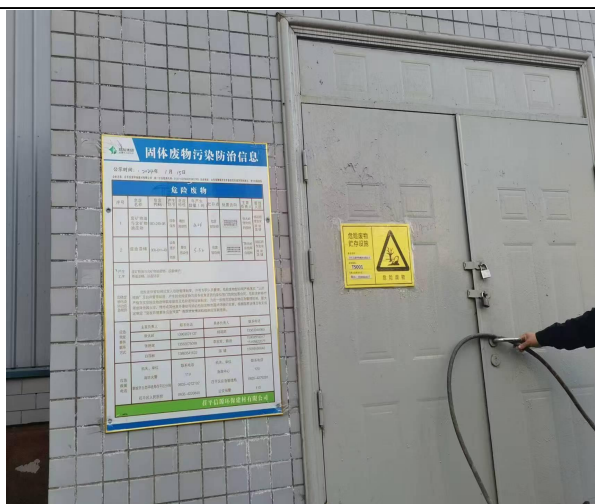
图11 危废暂存间外部
