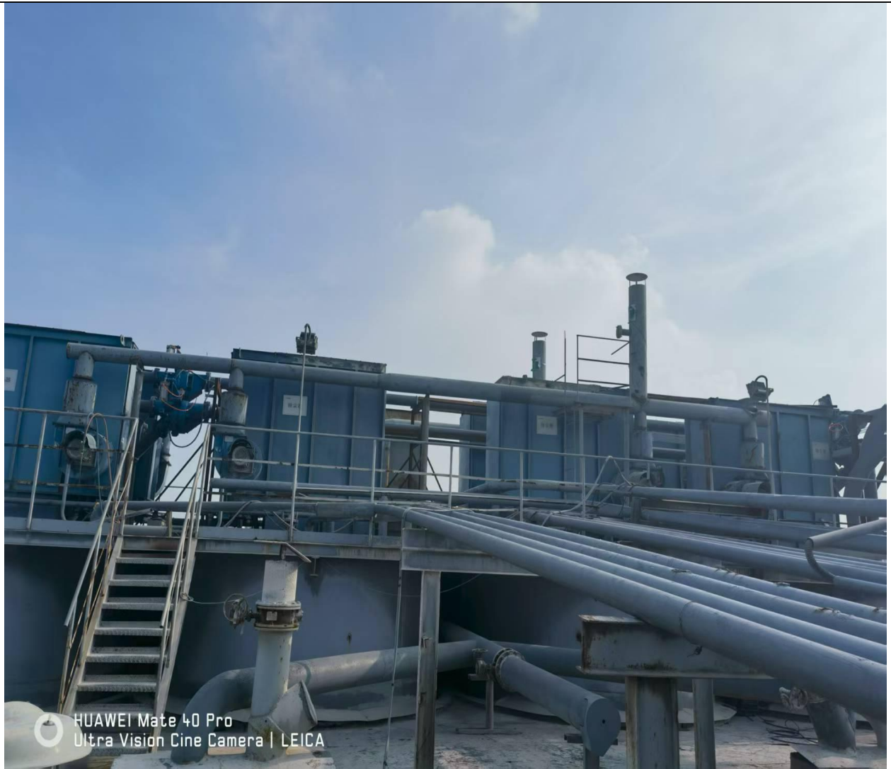
图10 脉冲布袋除尘器
